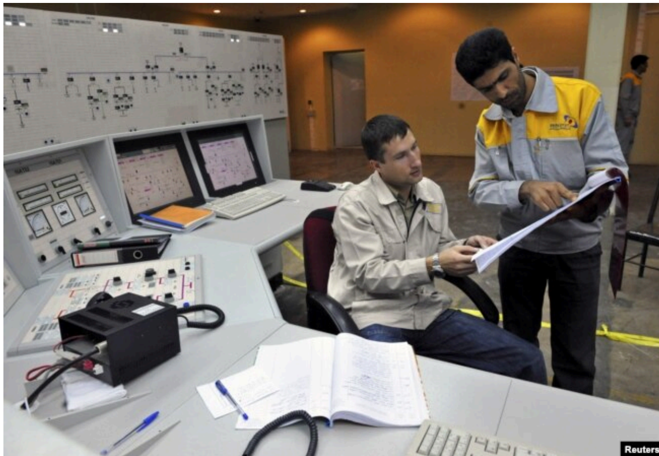
Російські та іранські інженери-ядерники на будівництві енергоблоку № 1 Бушерської АЕС. 2009 рік
