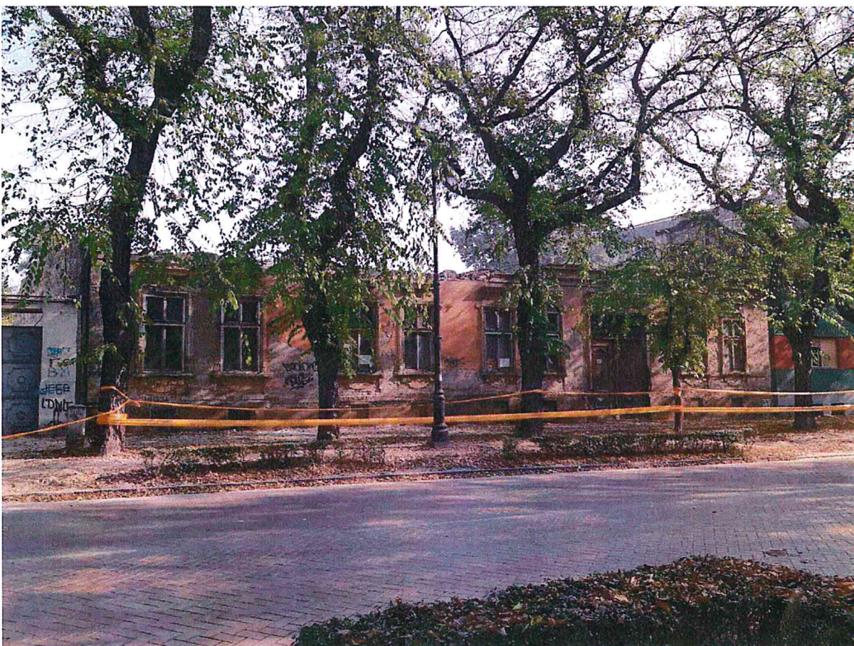
Објекат под бројем 43 који се руши у оквиру ПКИЦ Улица Браће Радић у Суботици (28.10.2019)
