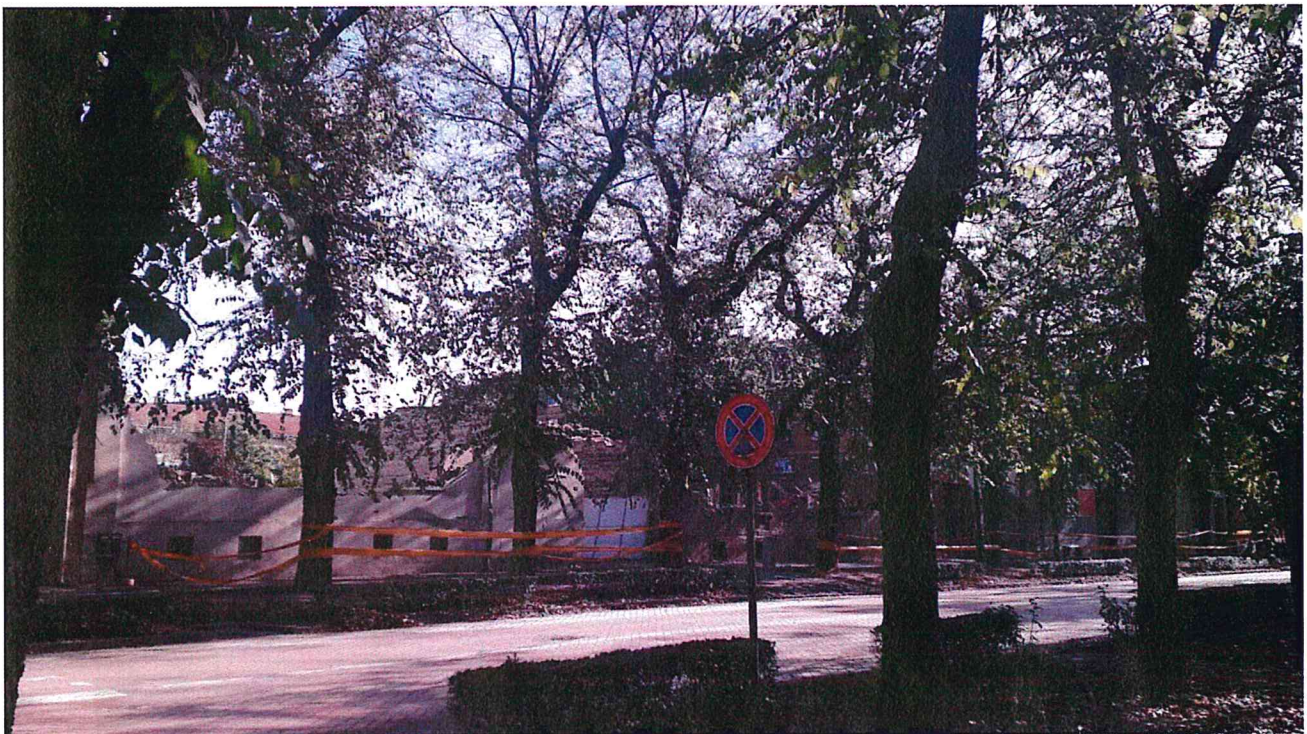
Објекти под бројевима 41-45 који се руши у оквиру ПКИЦ Улица Браће Радић у Суботици (31.10.2019)
