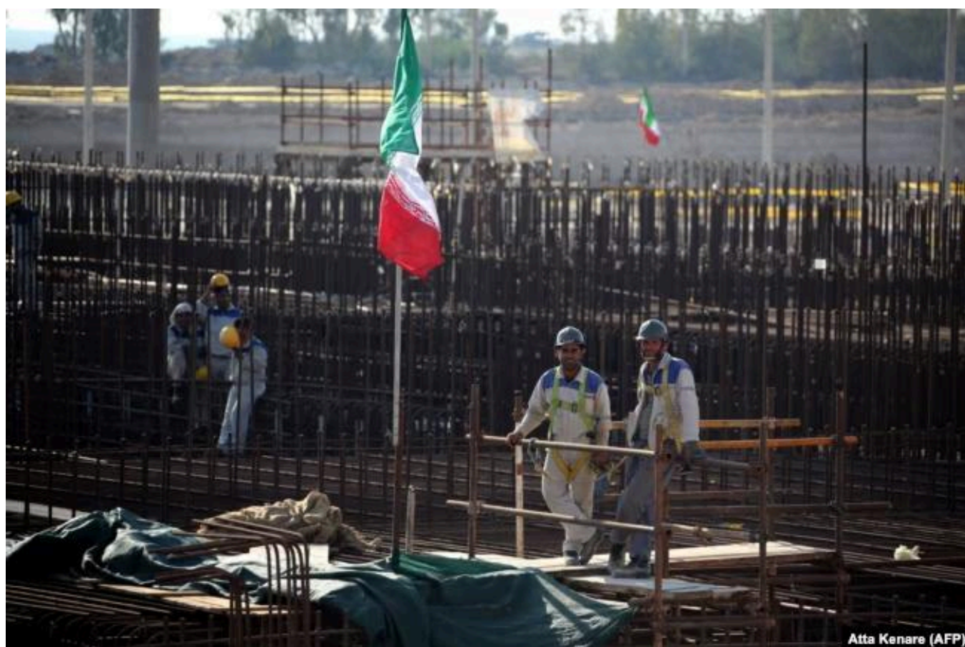
Строительная площадка энергоблока N2 Бушерской АЭС во время официальной церемонии начала работ на объекте. 10 ноября 2019 года
