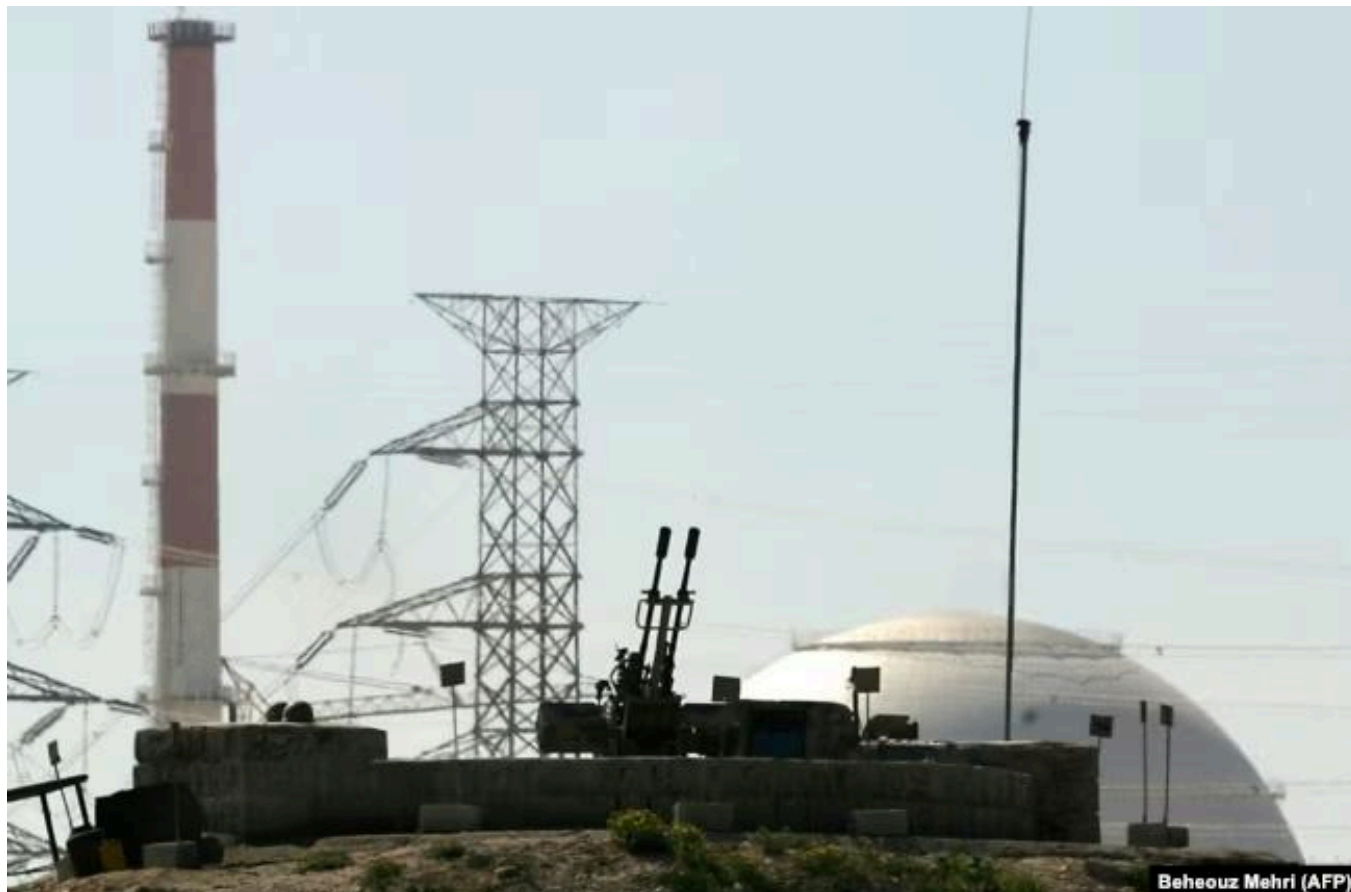
Средства ПВО Ирана перед 1-м энергоблоком Бушерской АЭС
