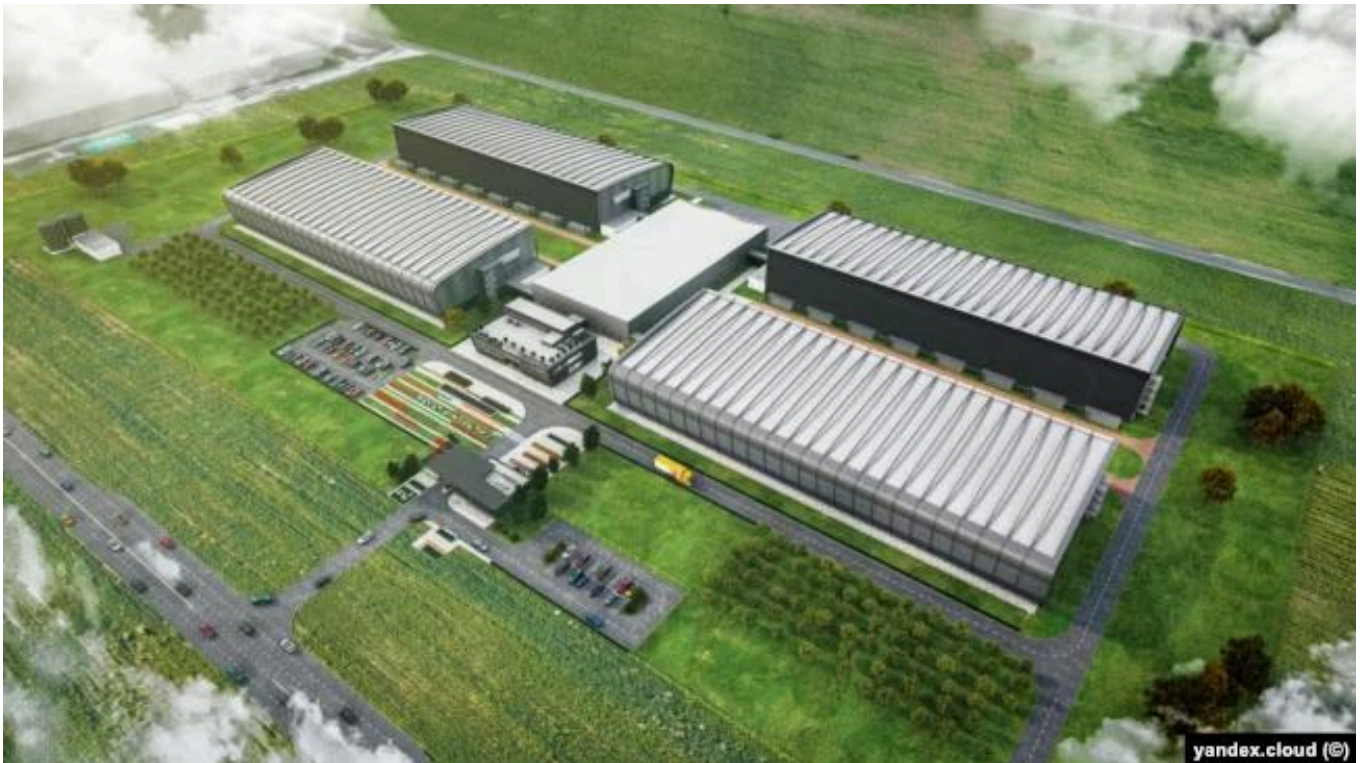
Дата-центр "Яндекса" под Калугой
