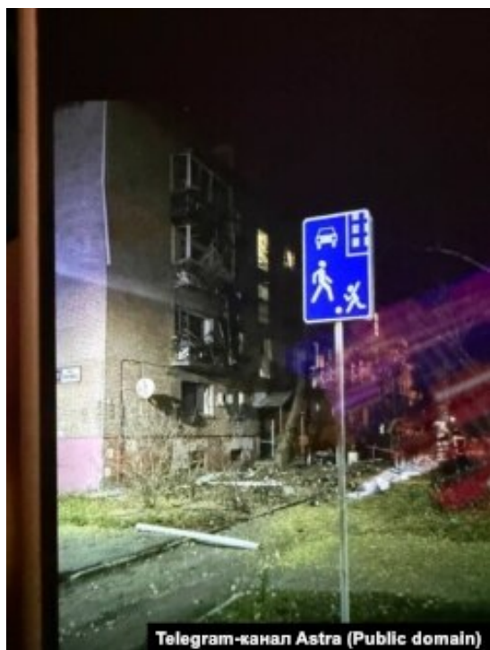
Поврежденный дом в Балаково
