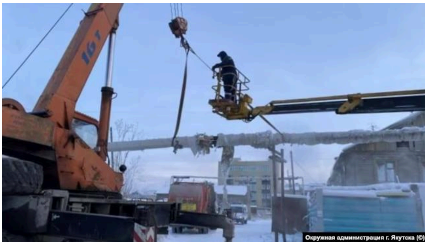
Ремонт теплосетей в Якутске
