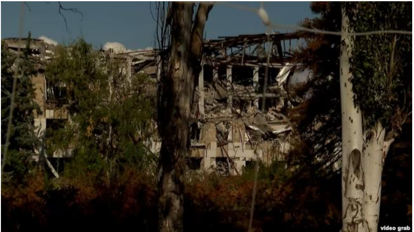
Разрушения в Краматорске после российских обстрелов
