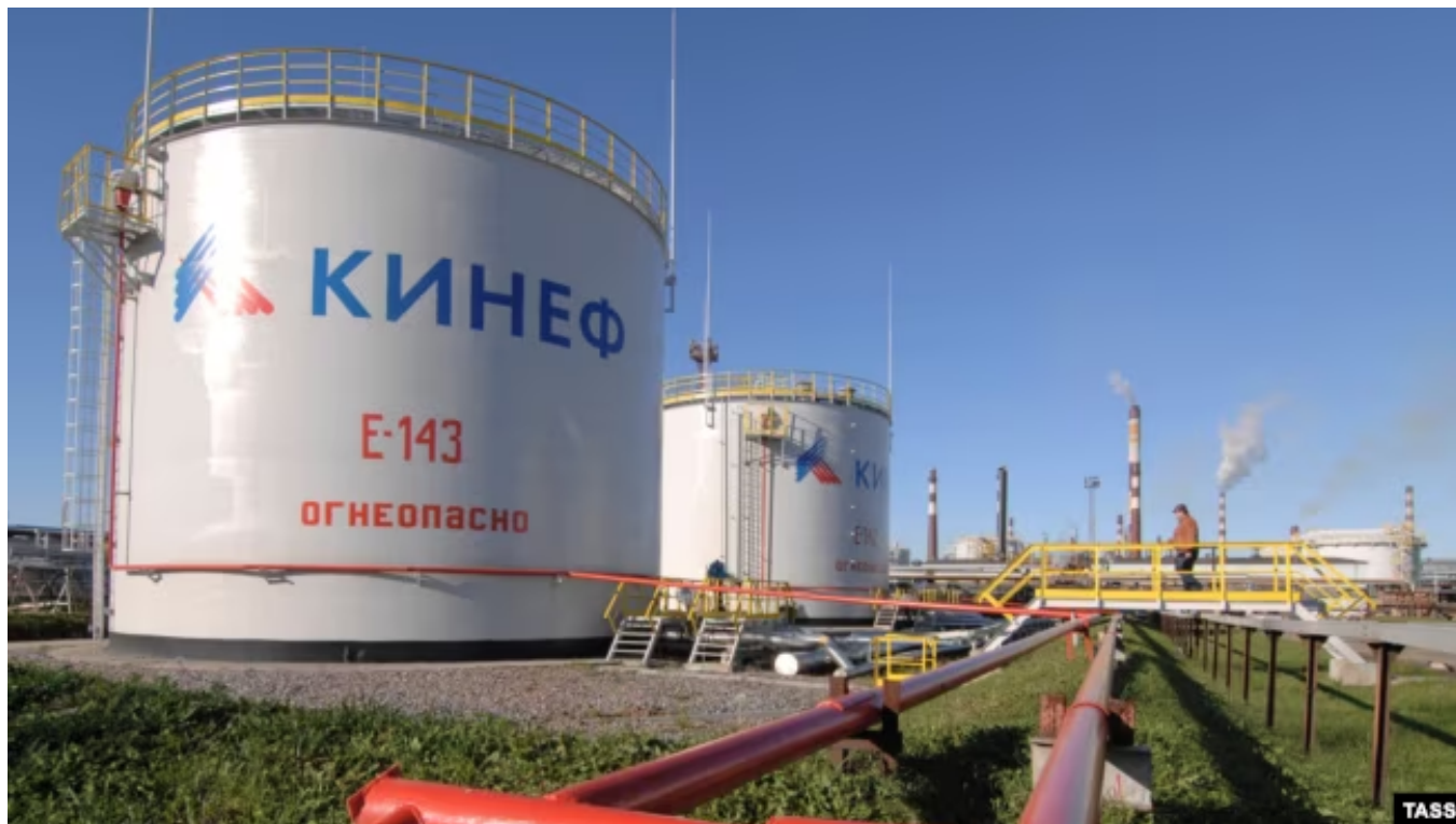
Технологические установки на территории нефтеперерабатывающего завода ООО "ПО "Киришинефтеоргсинтез"
