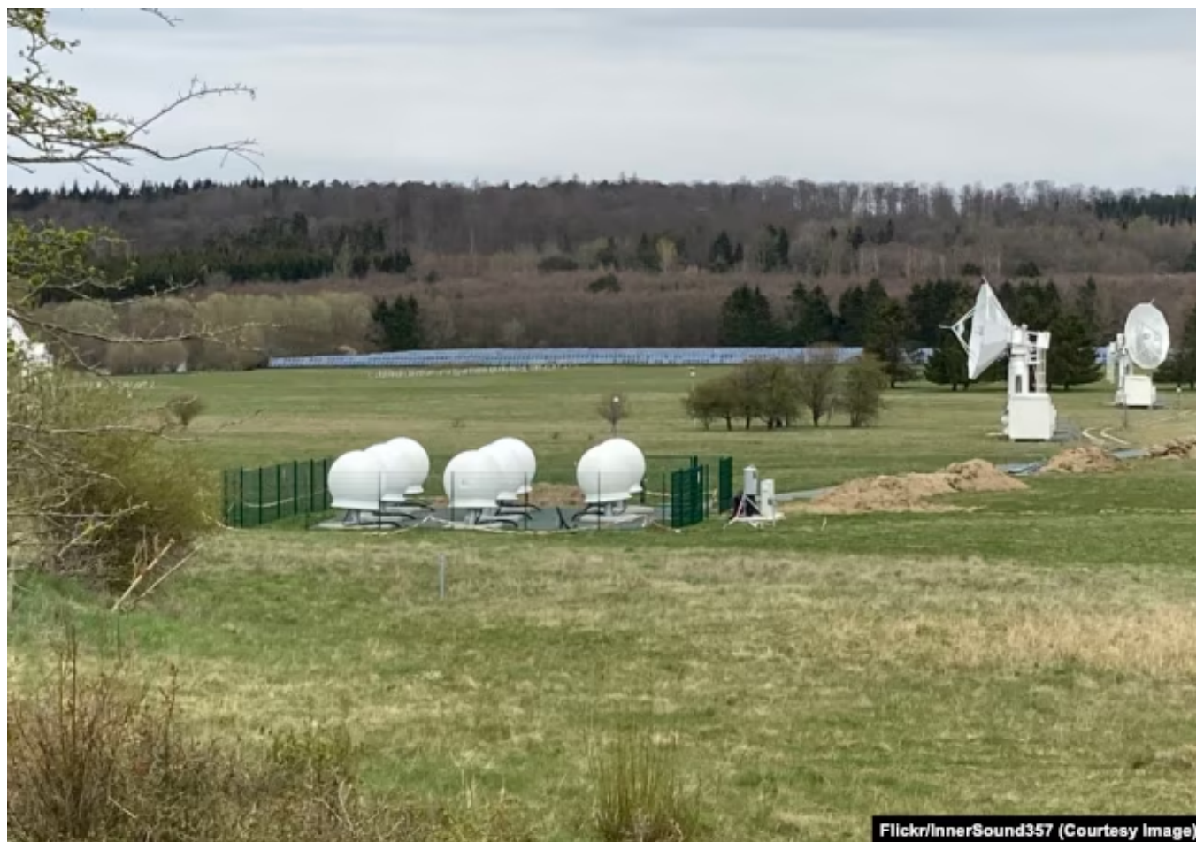
Наземный шлюз Starlink (слева на фото) в Германии
