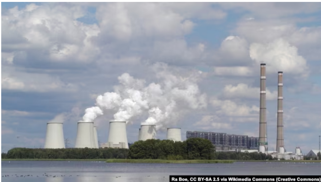
Угольная электростанция Йеншвальде
