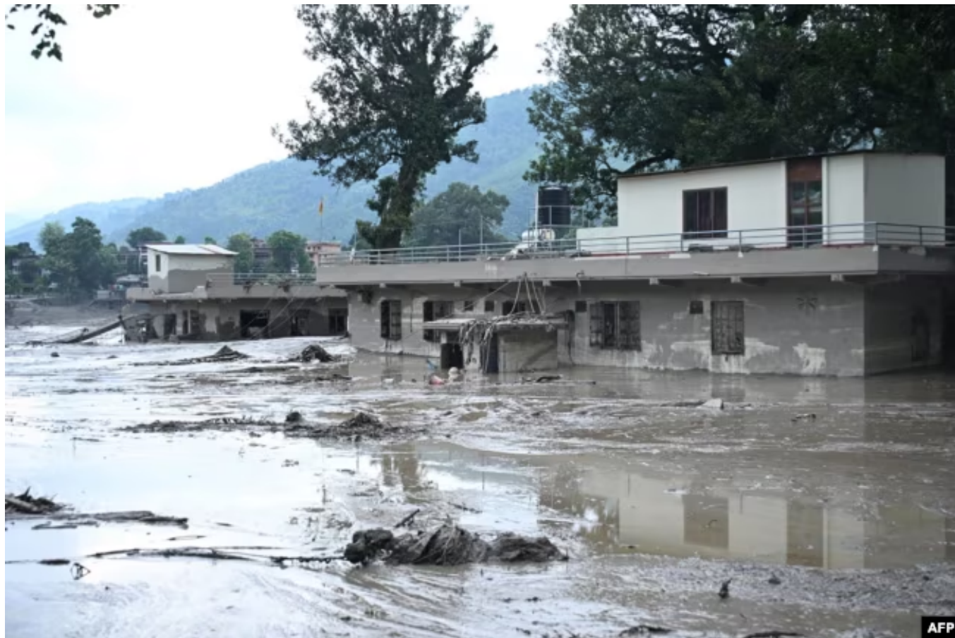
Затопленные и заваленные грязью и илом дома после внезапного наводнения в селении Девгхат. Непал, 26 августа 2026 года
