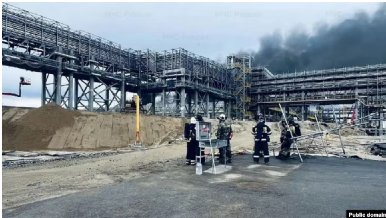
Площадка газохимического завода "Амурский" после пожара
