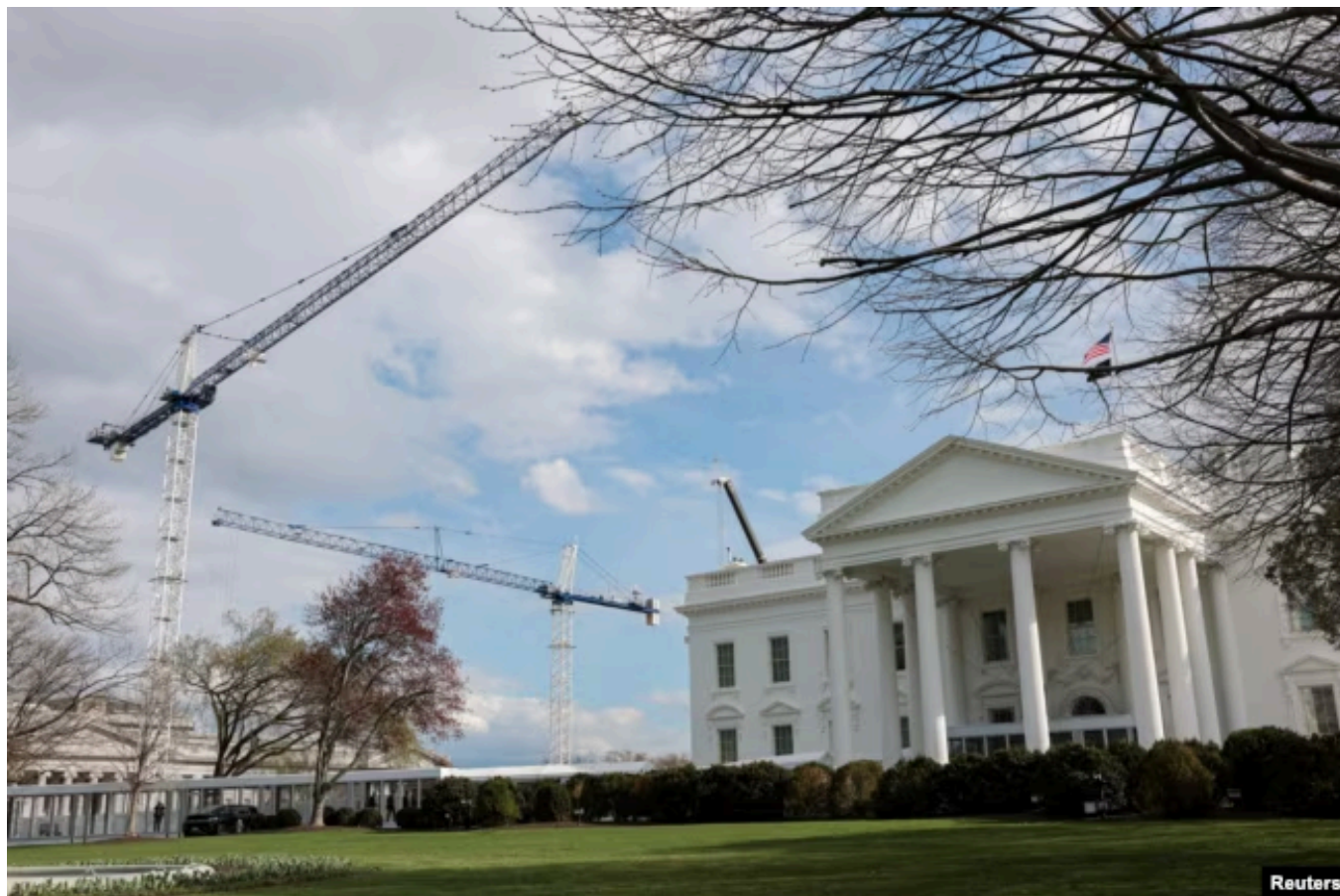
Строительные краны у Восточного крыла Белого Дома
