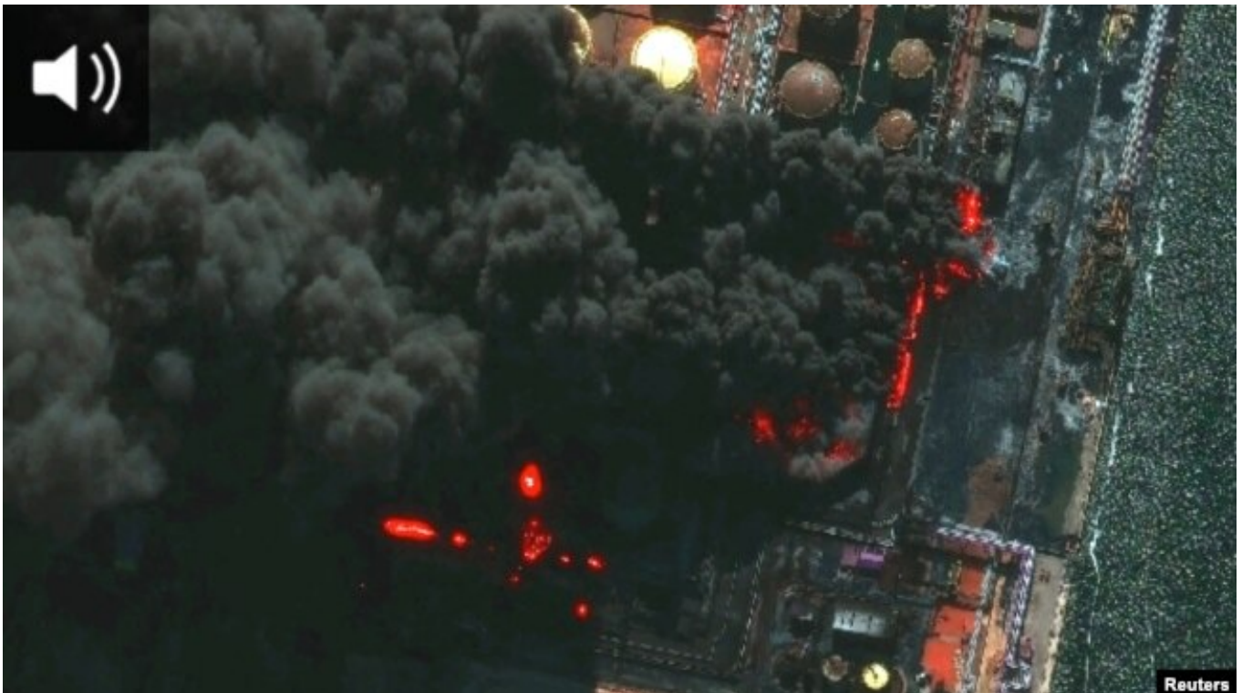
Пожар на НПЗ в Усть-Луге в Ленинградской области
