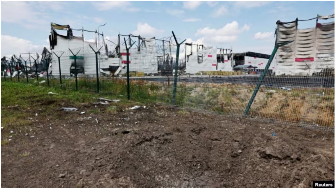
Выгоревший склад Wildberries в Электростали
