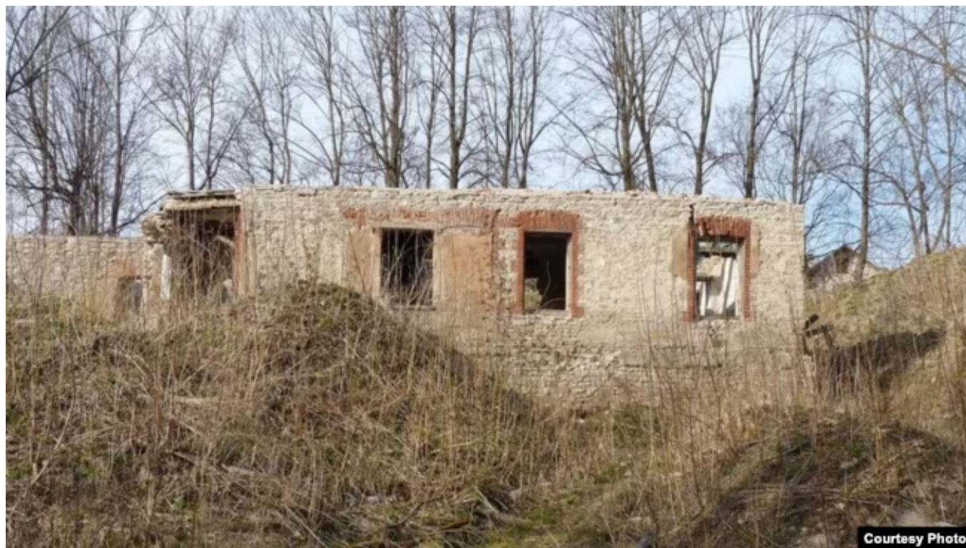
Дом жилой Оглоблиной - еще до окончательного разбора
