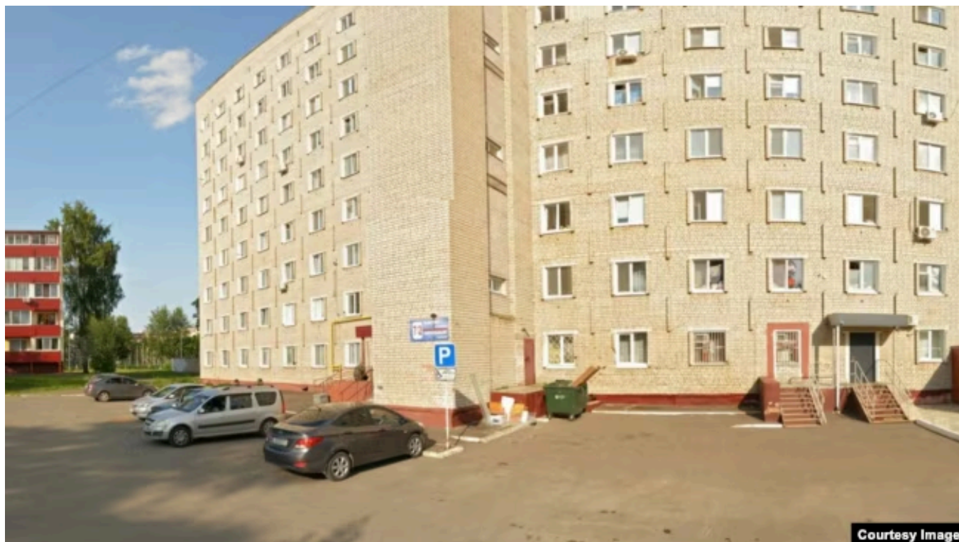
Здание в Нижнекамске по адресу Школьный бульвар, 7/2. Фото: Яндекс.Карты
