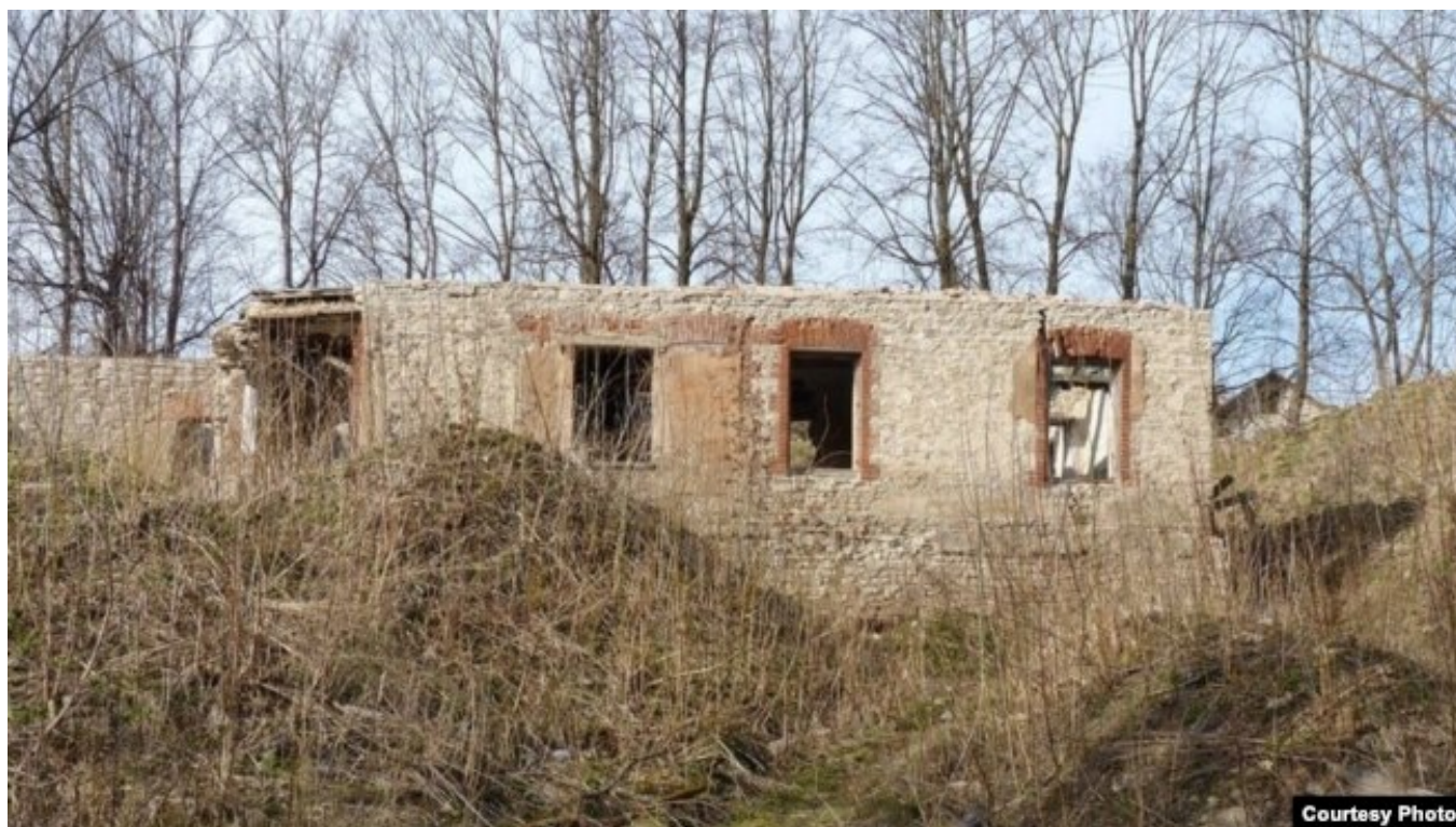
Дом жилой Оглоблиной - еще до окончательного разбора
