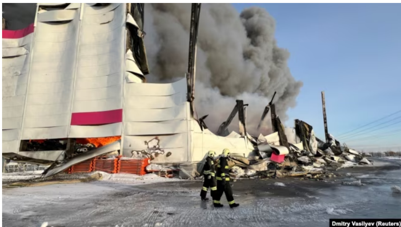
Склад Wildberries в Петербурге
