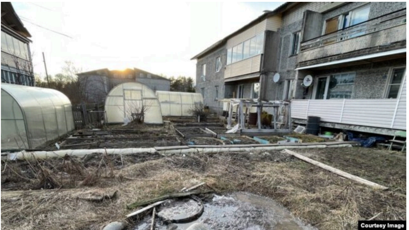
Канализационные стоки во дворах
