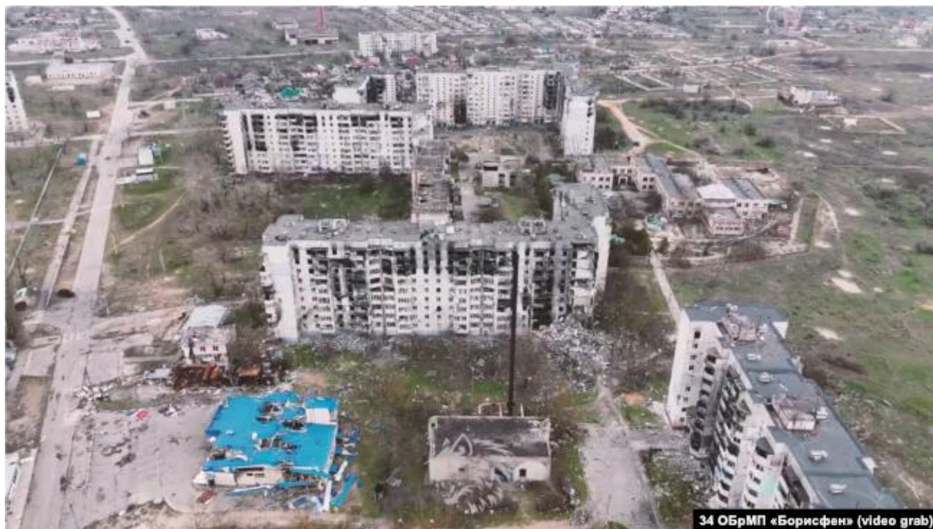
Разрушенные дома в Олешках
