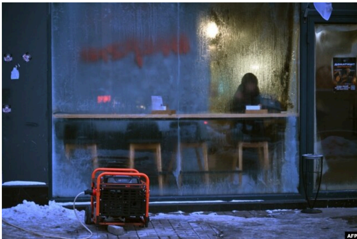
Генератор на входе в ресторан в центре Киева. 18 января 2026 года
