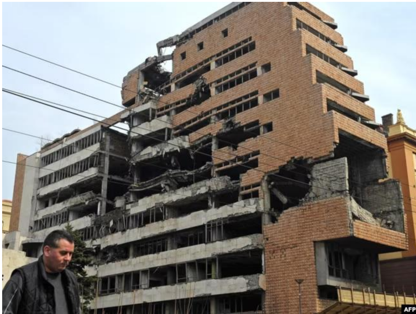
Разрушенное здание МВД Сербии после ночной бомбардировки Белграда силами НАТО
