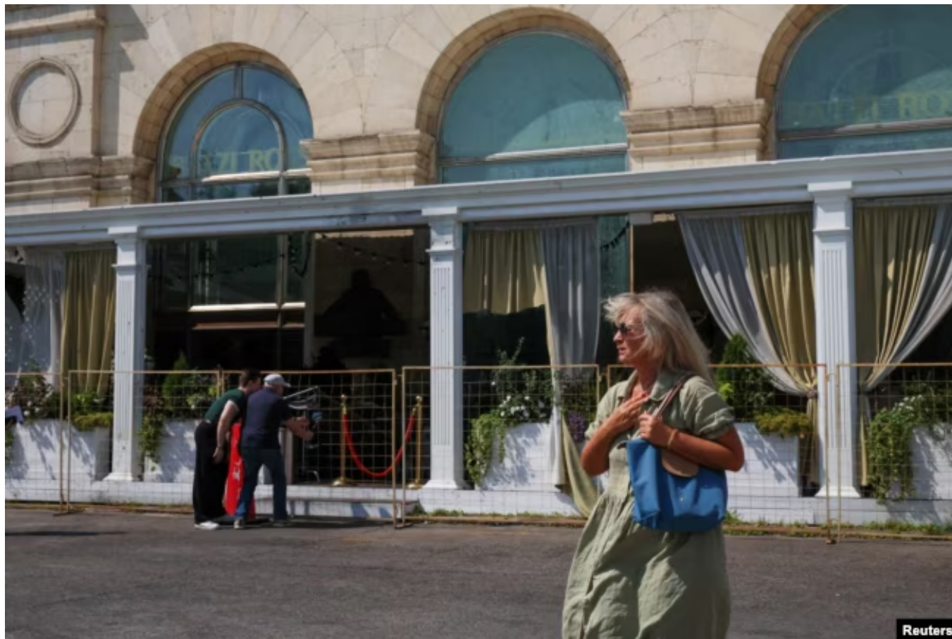
Помещение ресторана, поврежденное взрывом
