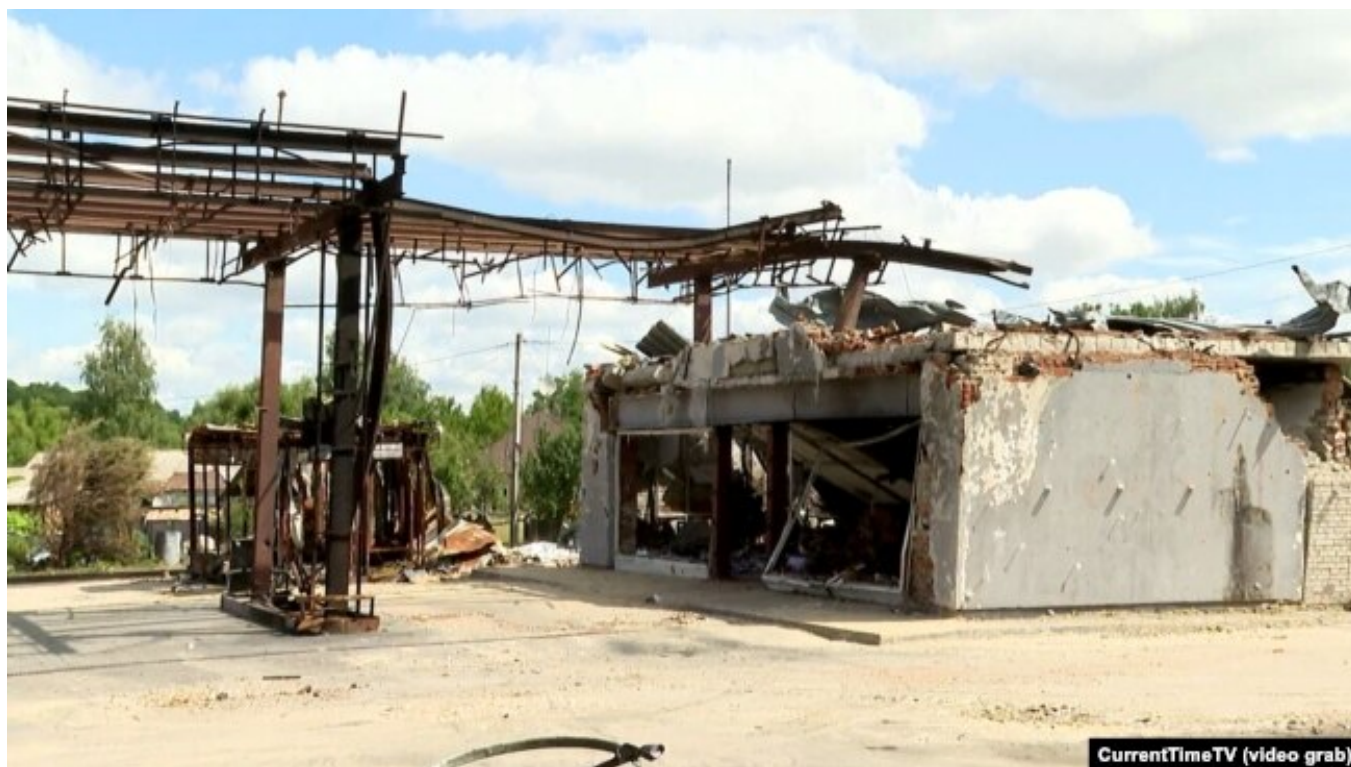
Одна из разрушенных АЗС
