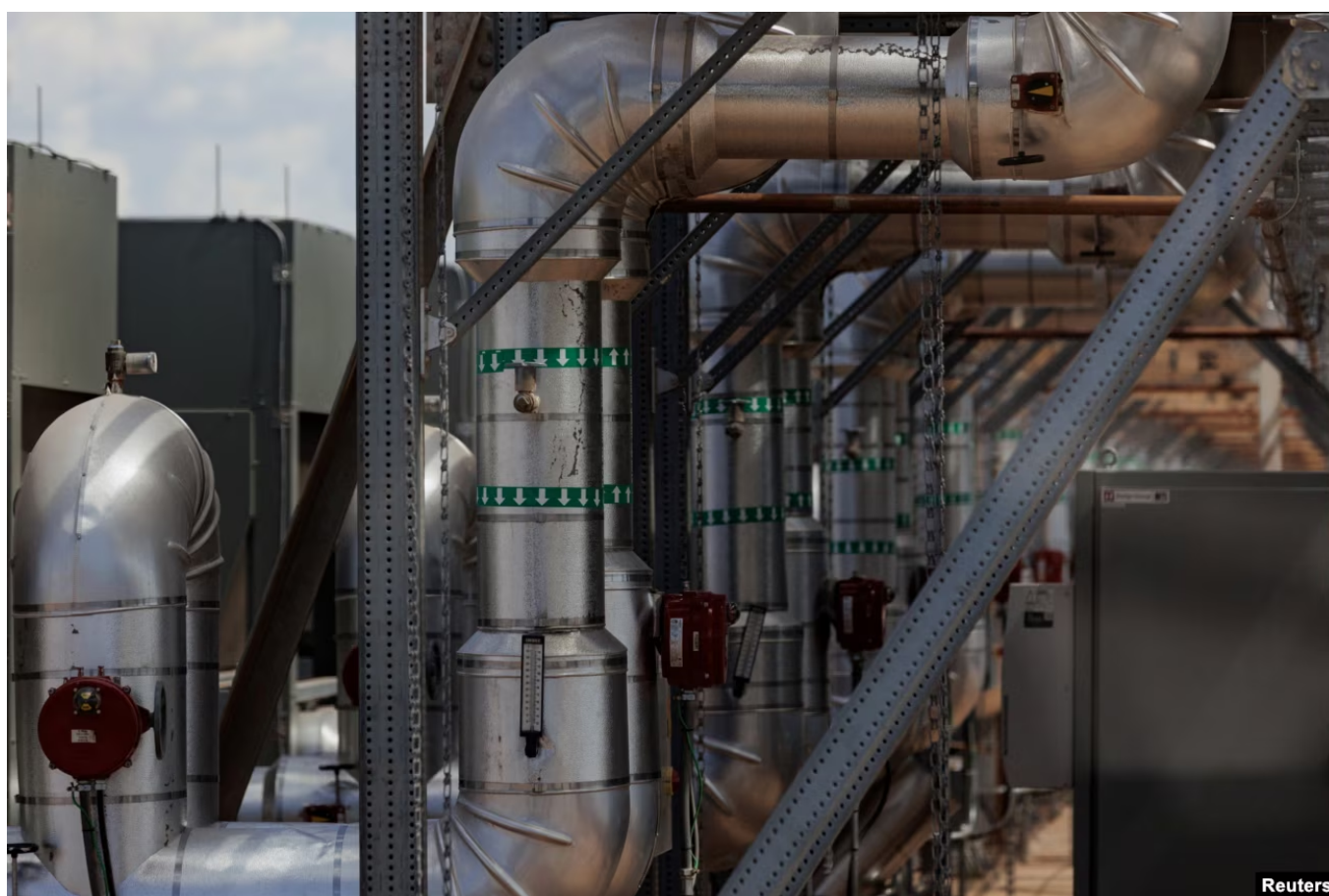
Трубы, входящие в контур водяного охлаждения графических процессоров в центре обработки данных OpenAI в Абилине, штат Техас, США. 23 сентября 2025 года. Фото: Reuters
