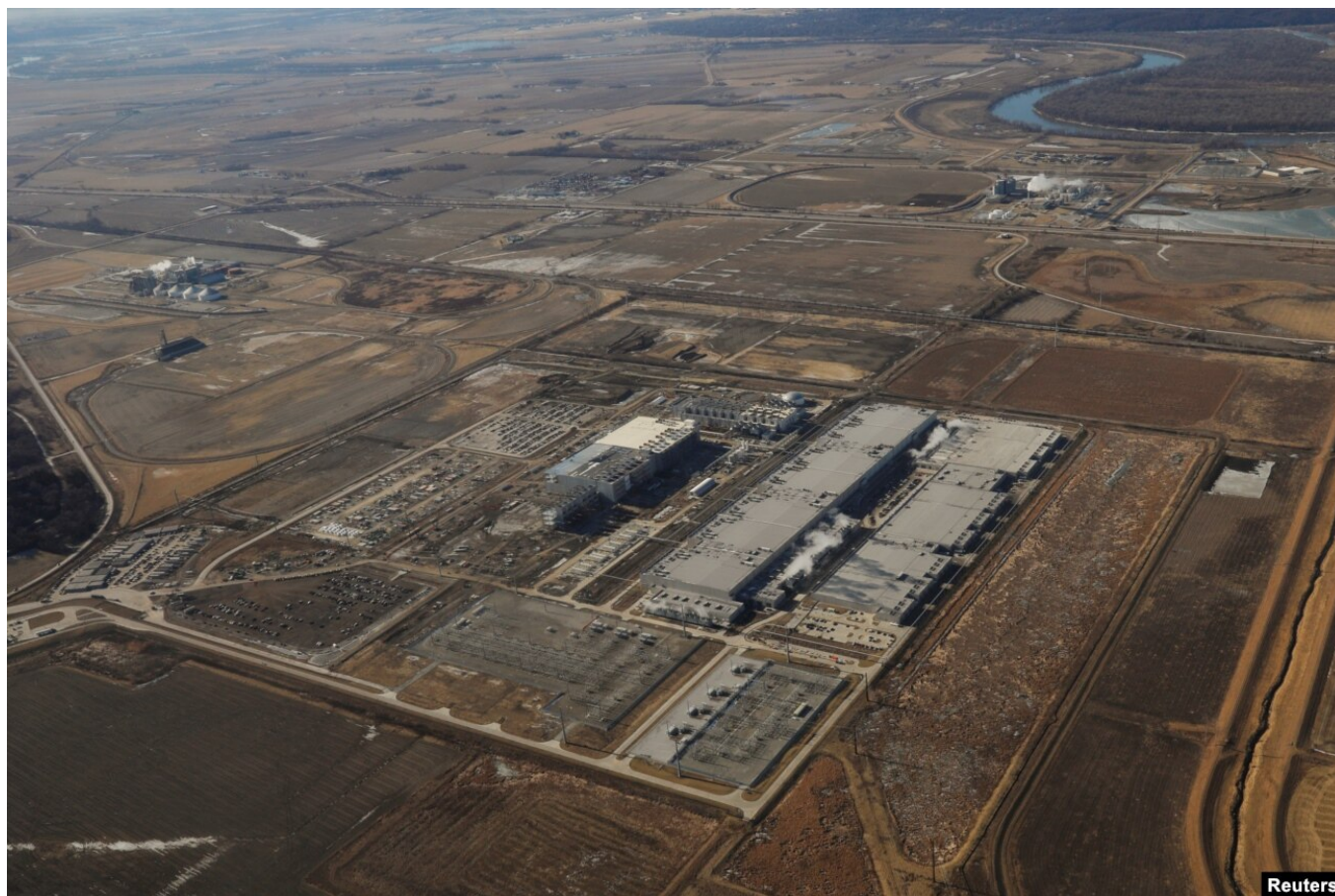
Объект Google Data Center Southland, снятый с воздуха в городе Каунсил-Блаффс, штат Айова, США, 4 января 2019 года. Фото: Reuters
