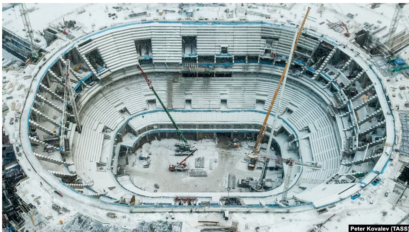
Строительство СКА-Арены, декабрь 2021 года
