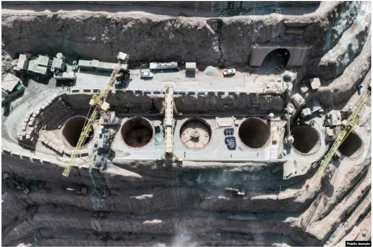
Участок Рогунской плотины в процессе строительства, 2024 год
