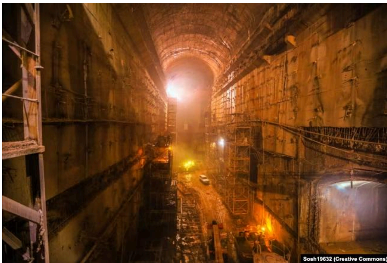
Подземное помещение строящейся Рогунской ГЭС, 2019 год
