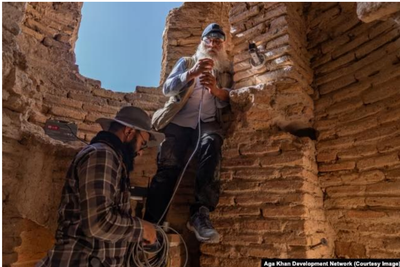
Рабочие внутри Джамского минарета во время проведения реставрационных работ
