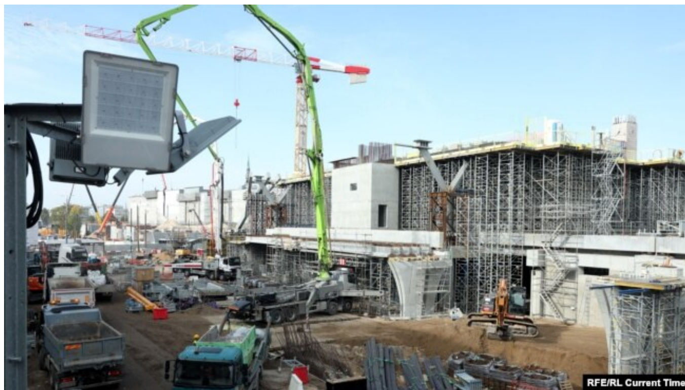
Строительство станции в Риге в рамках проекта Rail Baltica
