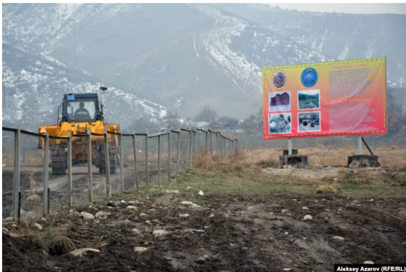
Строительные работы по прокладке автодороги через охранную зону Талхиза, ноябрь 2016 года
