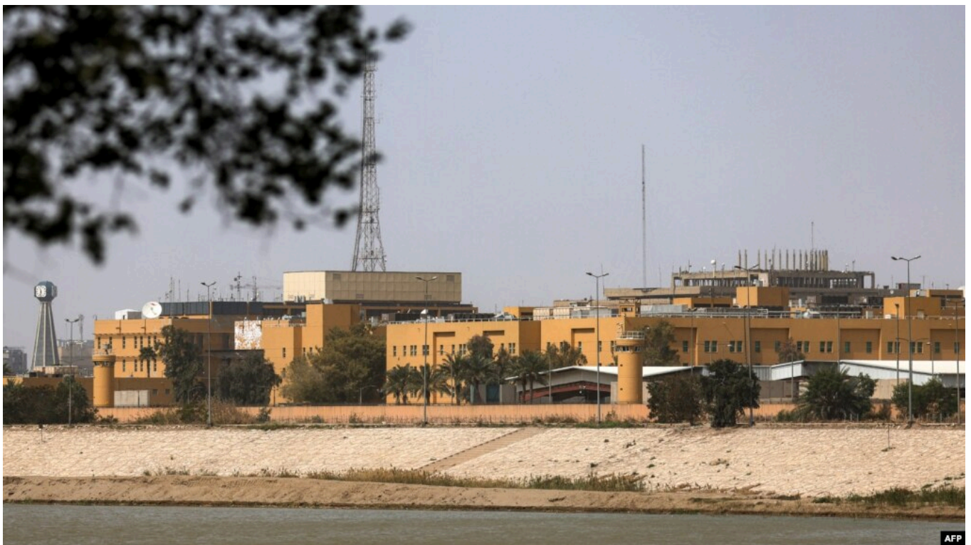
ساختمان سفارت آمریکا در منطقه سبز بغداد
