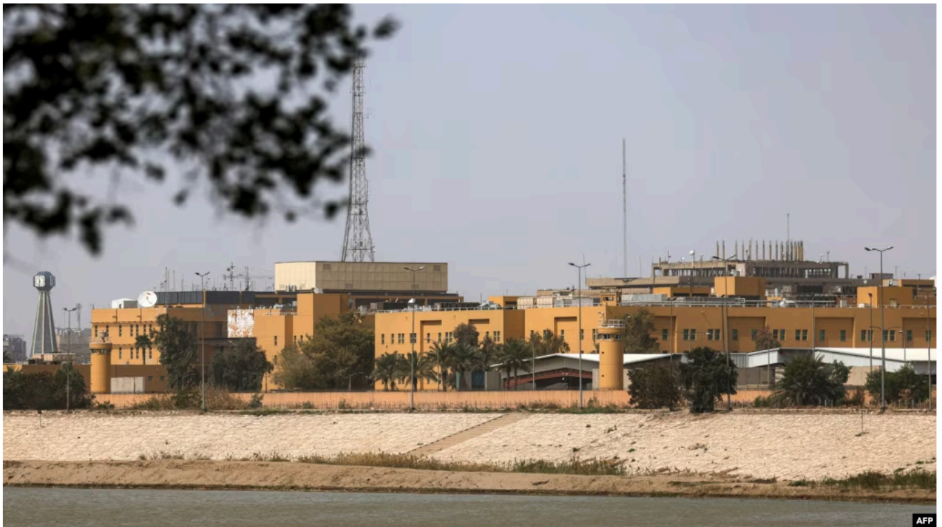
ساختمان سفارت آمریکا در منطقه سبز بغداد
