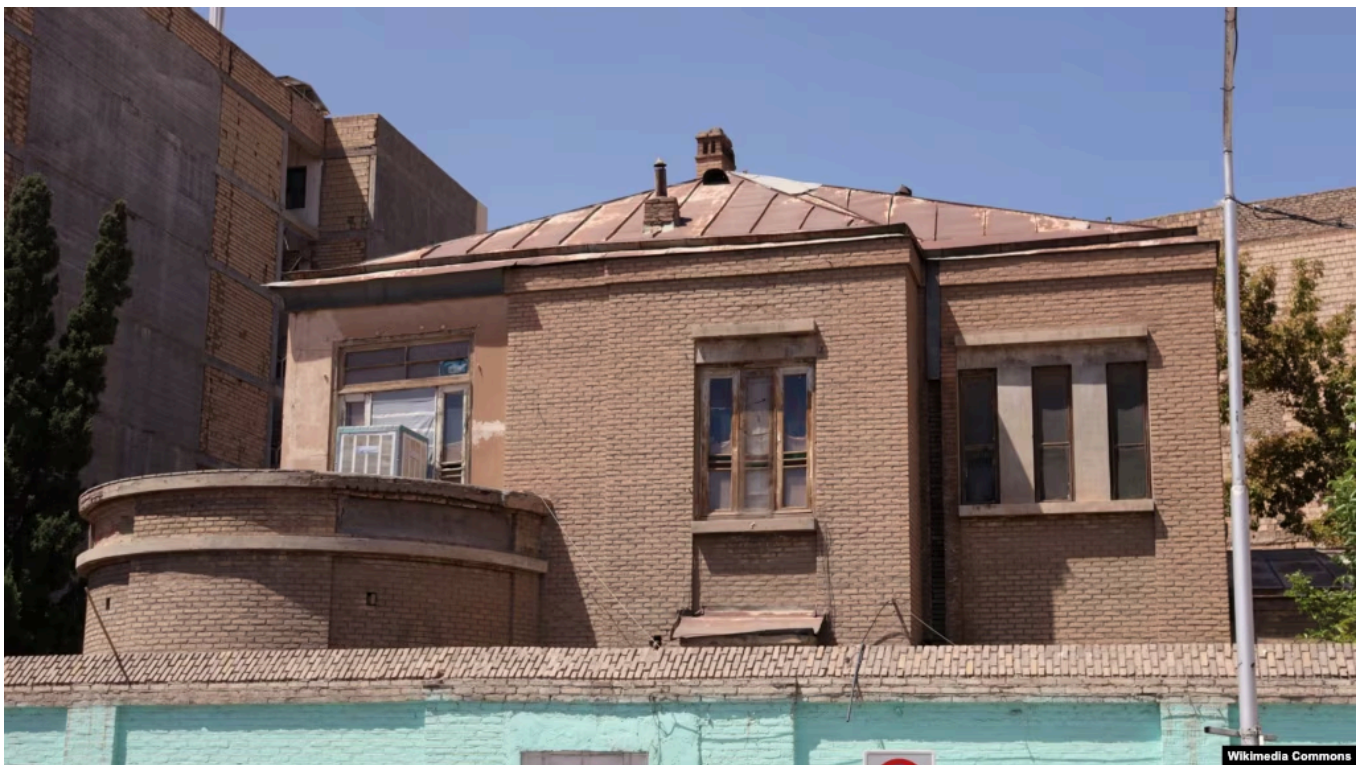
نمای شرقی ساختمان کلیسای انجیلی در مشهد قبل از تخریب
