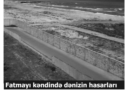
Fatmayı kəndində dənizin hasarları
